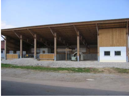
Neuer Kälberstall am Standort Grub
